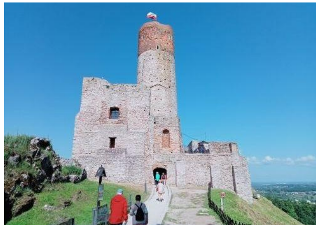
Brama wschodnia i wieża więzienna.
