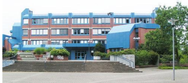
Budynek Wydziału Fizyki (2005), obecnie należący do Wydziału Matematyki, Informatyki i Fizyki.
