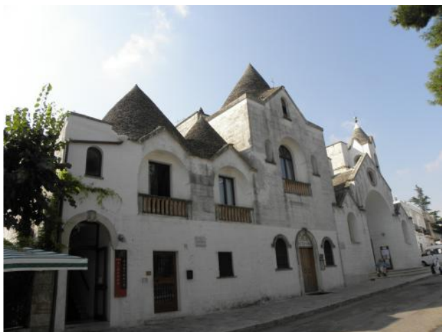
Kościół św. Antoniego Padewskiego z 1927 r. Dachy ułożone są z kamieni w tradycyjny sposób w kształcie stożka. Dzwonnica ma wysokość 18,3 m.
