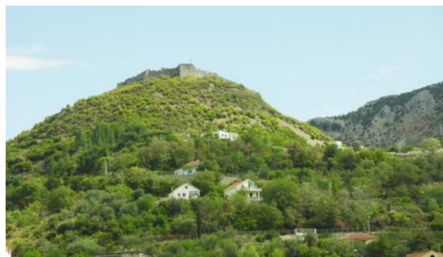
Forteca Lezha. Budowano ją od VI do XVIII w.
